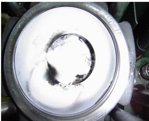
Fig. 5 Dépôts de siloxanes dans le moteur en mode dual-fuel.
