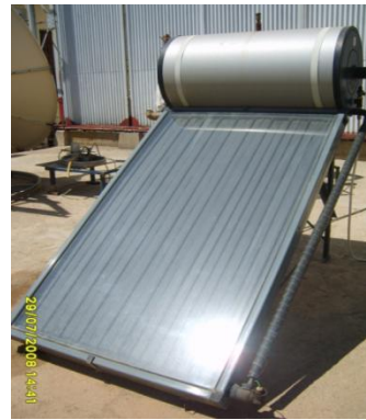
Figure1 : Chauffe eau solaire à thermosiphon
