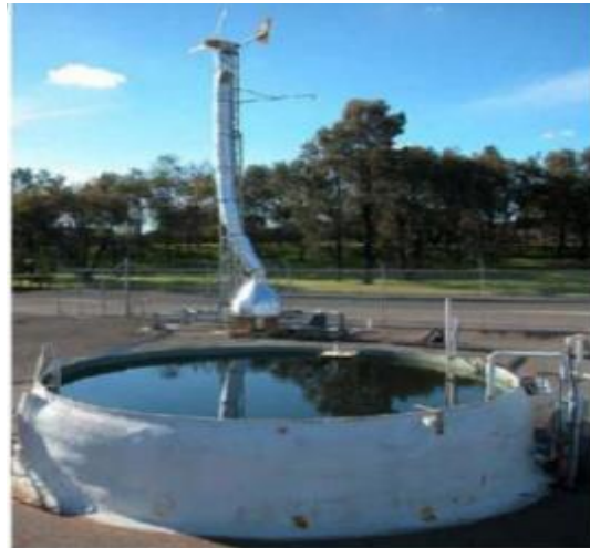
Fig. 8 Prototypes (2002) de hauteur de : (a) 8.8m à Wuhan, China [11]; (b) 8m à Bundoora, Australia [12].
