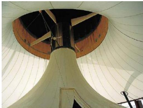
Fig. 5 Photo des différents compartiments de la centrale à cheminée solaire de Manzanara, (a) Photo globale, (b) la tour, c. le collecteur et (c) la turbine éolienne
