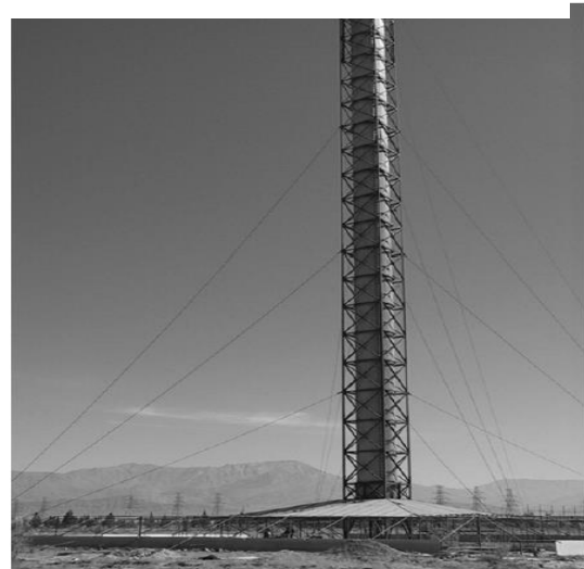
Fig. 7 Photo de la centrale à cheminée solaire pilote de Kerman en Iran [6]
