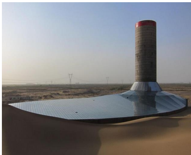
Fig. 6 Photo de la centrale à cheminée solaire de Jinshawan, en Mongolie en Chine.
