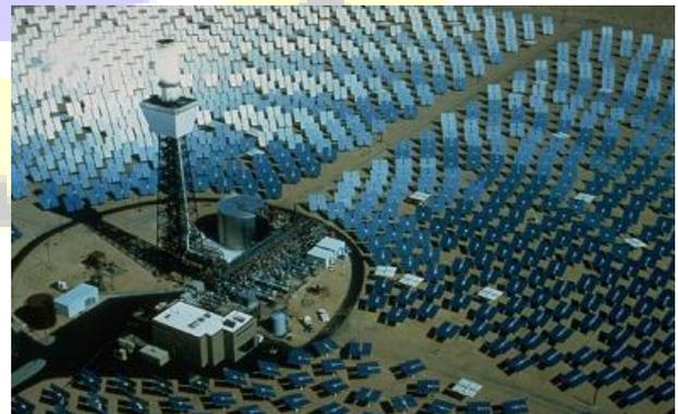
Fig. 1 Solar One (Californie) utilise 1818 héliostats [8].
