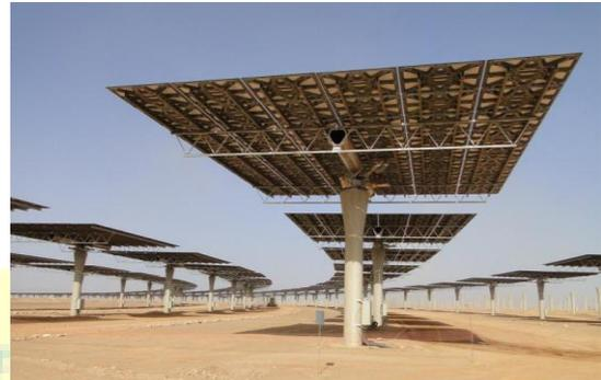
Fig. 8 Héliostat de SENER de 175.7 m<sup>2</sup> [19].
